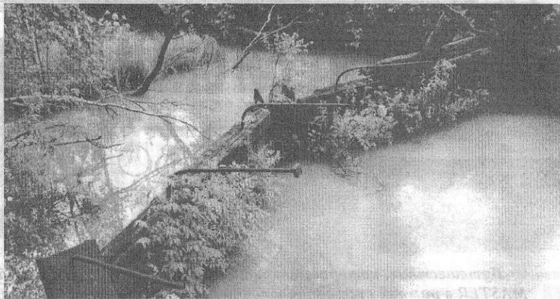
▲ До сих пор гидросооружения выполняют свою работу. Но людям она уже давно не нужна
